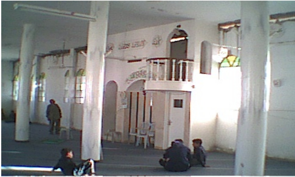
شكل (١٠): جدار القبلة الذي تم هدمه في مسجد أبي بكر الصديق في المساكن الشعبية الشرقية. (الباحث)
